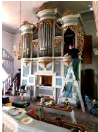
Demontagearbeiten an der Orgel
